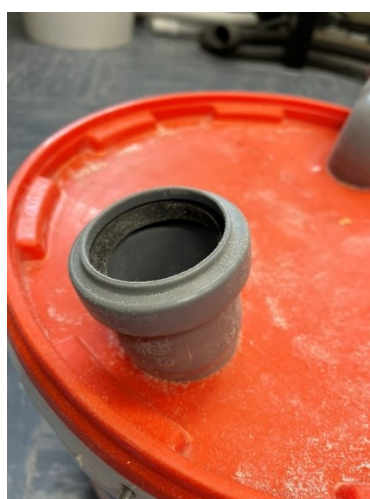
SLIKA 3. 3.11: VSTAVLJANJE PLASTIČNEGA RAVNEGA KOLENA V IZREZANO LUKNJO 2
