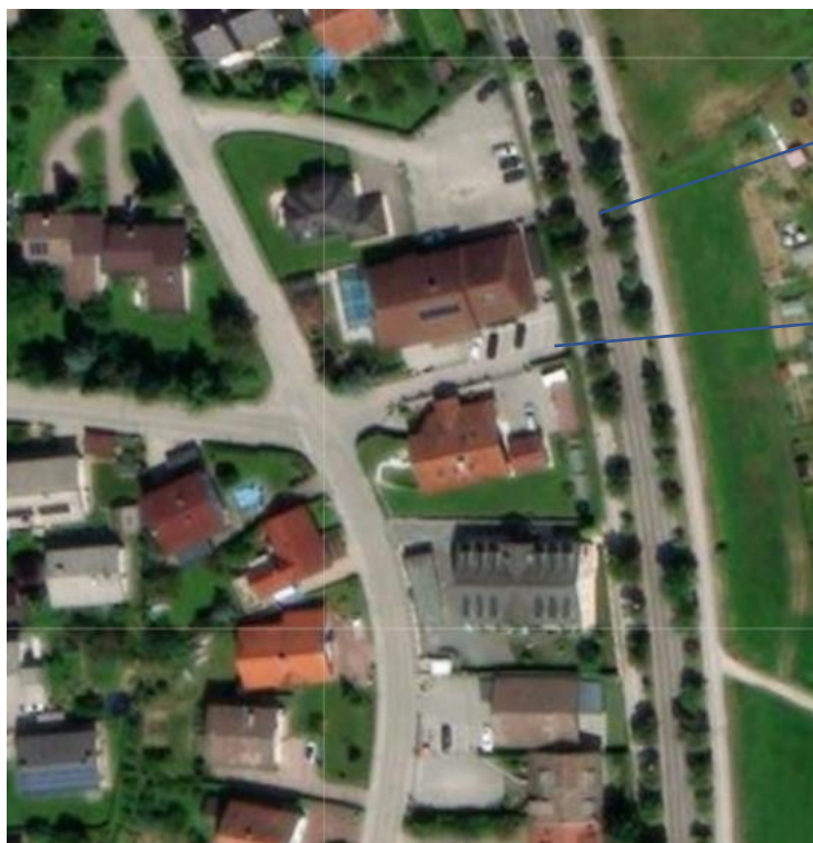
Slika št. 23: Odsek ceste v naselju Lava
