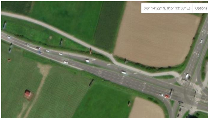
Slika št. 1: Odsek ceste in kolesarske poti Medlog – Levec
