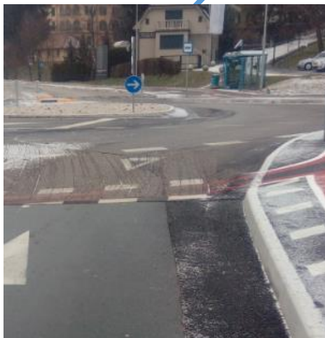
Slika št. 14: Vertikalna signalizacija
