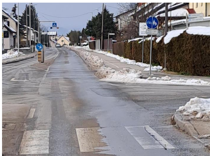
Slika št. 30: Detajl cestnega odseka na Ostrožnem, Celje
