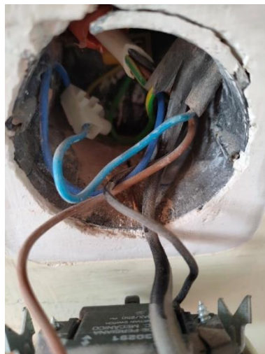
Slika 10: Vodniki za stikalom
