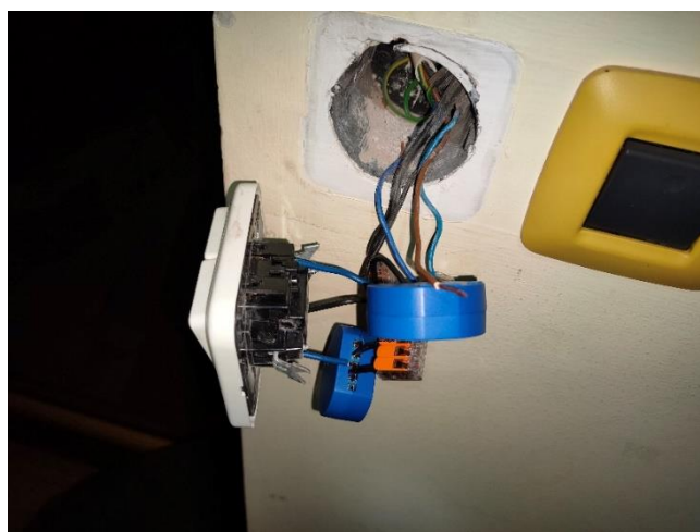
Slika 11: Vezava dveh relejev
