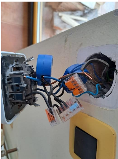
Slika 12: Končna vezava relejev na stikalo
