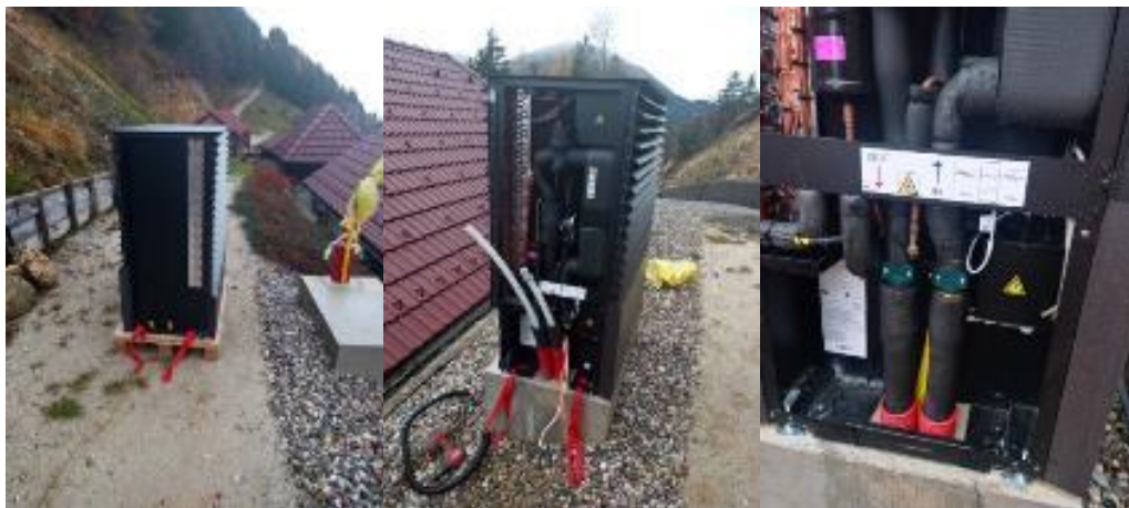
Slika 27: Postavitev zunanje enote TČ
