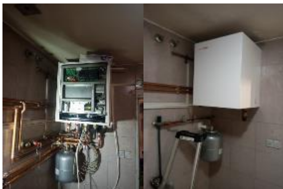
Slika 31: Notranja enota z elektroniko
