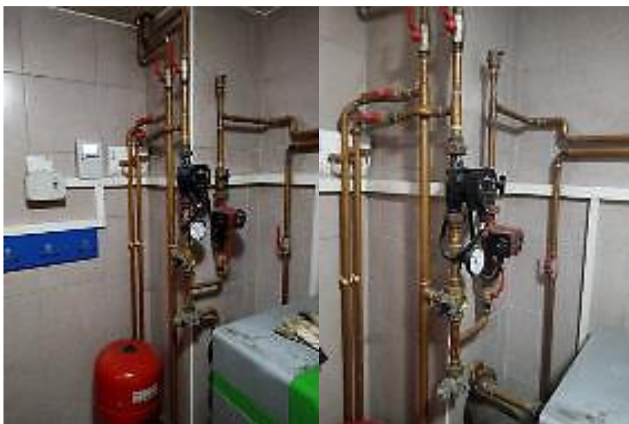
Slika 11: Kotlovnica pred posodobitvijo
