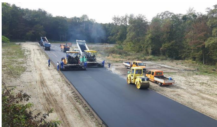
35 Obnavljanje asfaltne proge v Gaju na Dolenjskem.
