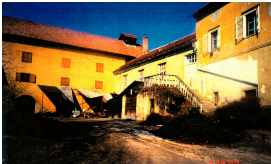
Slika 9: Na stanovanjsko stavbo se navezuje bivši rastlinjak. V ozadju je gospodarsko poslopje, ki je bilo po vojni prezidano v sušilnico hmelja
