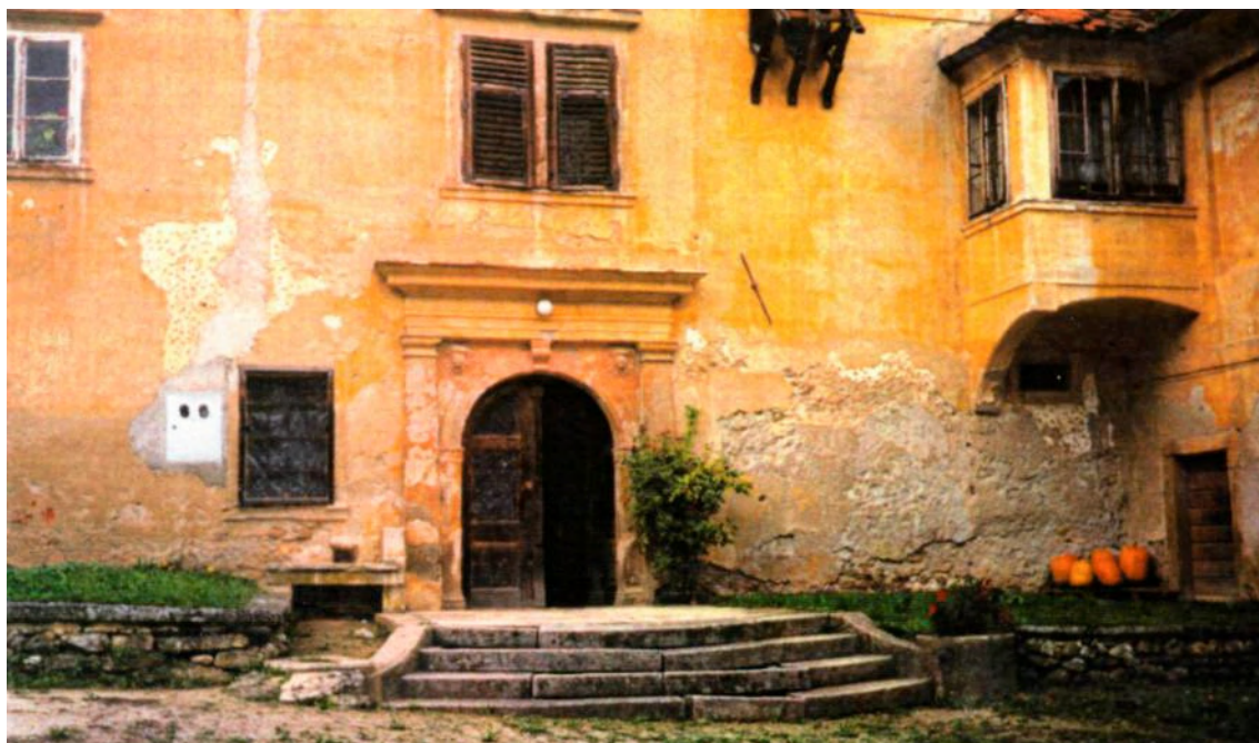
Slika 8: Dvonadstropna stanovanjska stavba z glavnim vhodnim portalom
