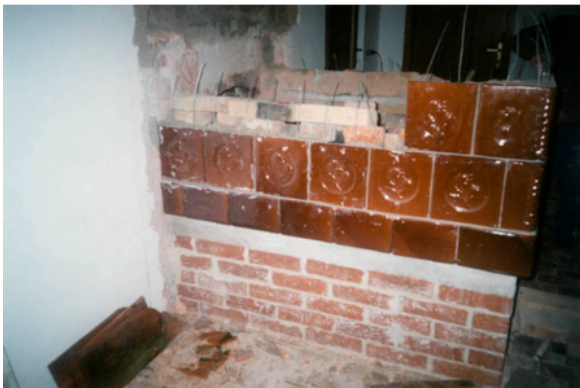
Fotografija 13: Rudi Kotnik postavlja krušno peč
