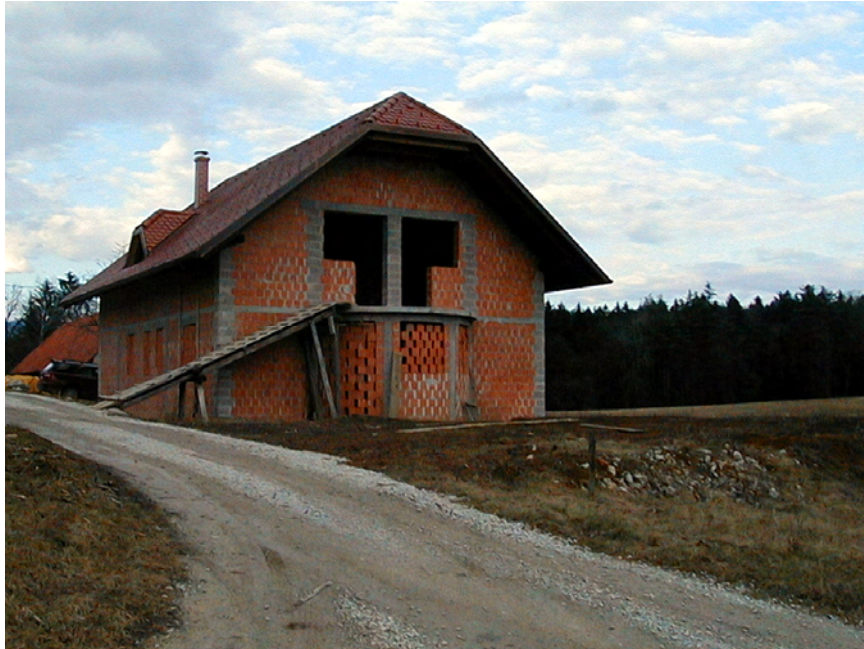
Fotografija 4: Primer novogradnje v novejšem delu Lahovne
