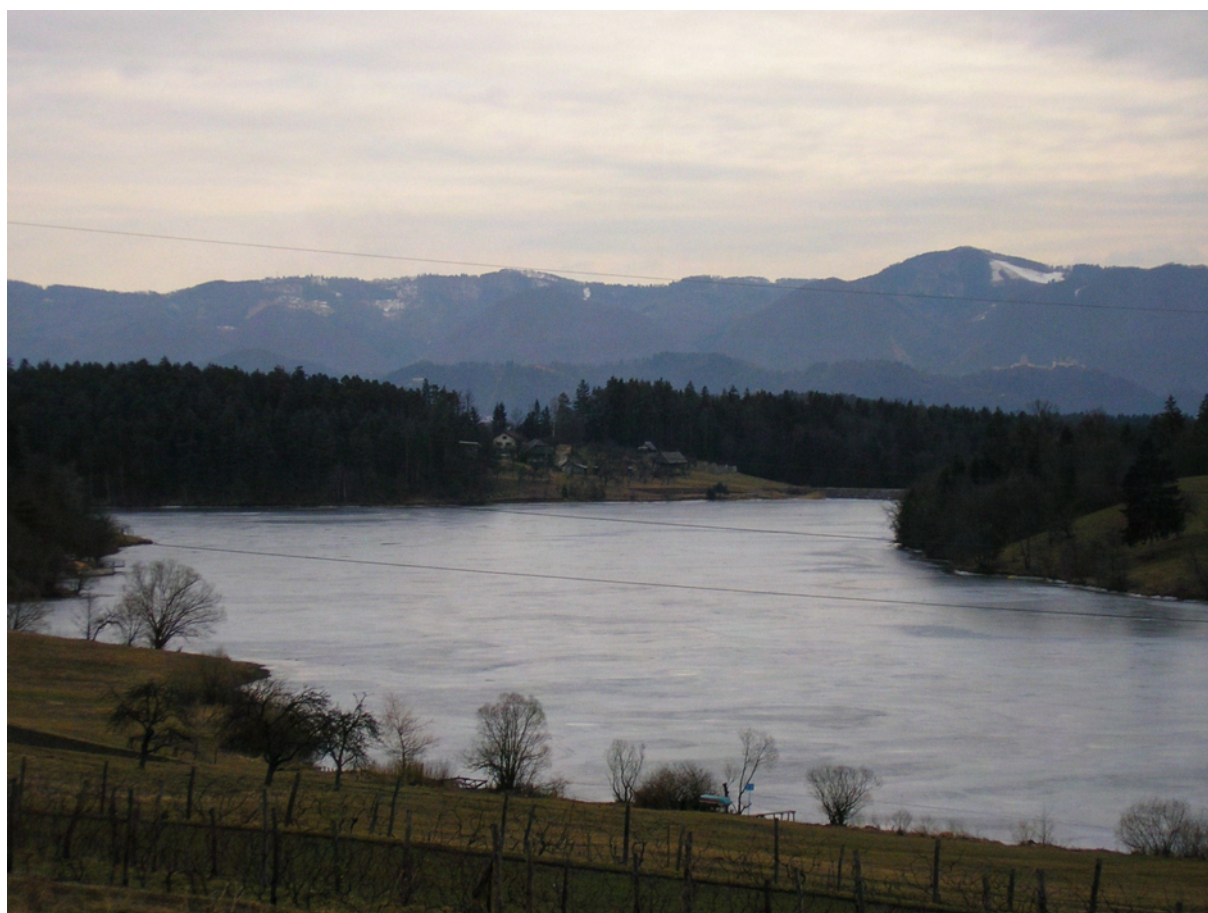
Slika 6 – pogled proti pregradi
