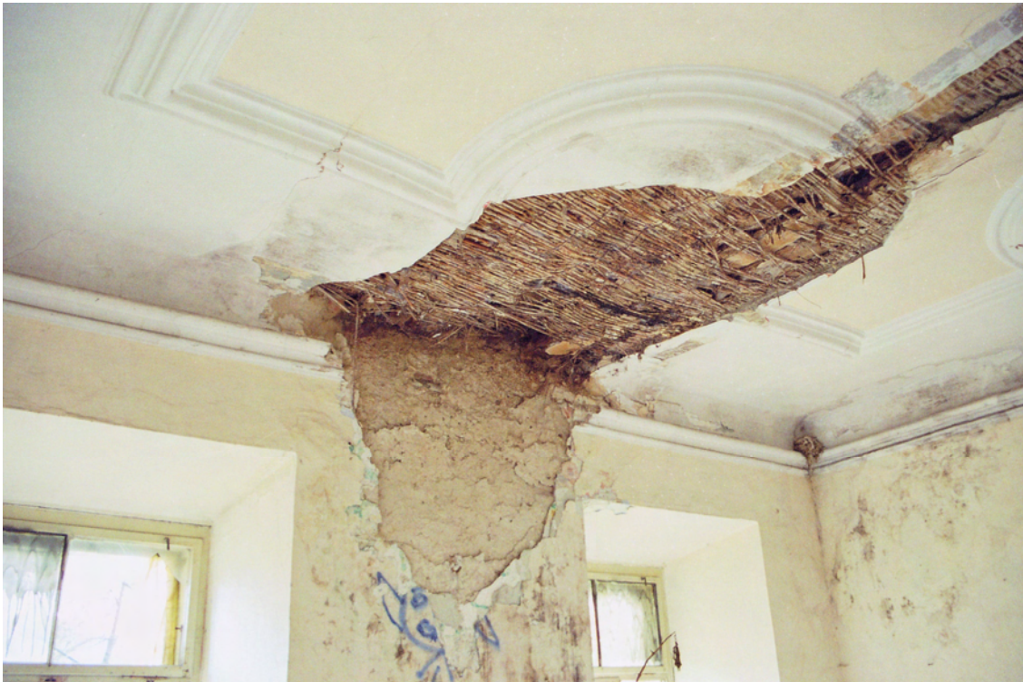
Slika 6. Voda, ki zateka skozi streho uničuje notranjost dvorca
