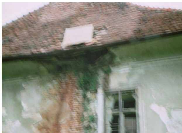
Slika 20. Uničena streha na vzhodni strani.
