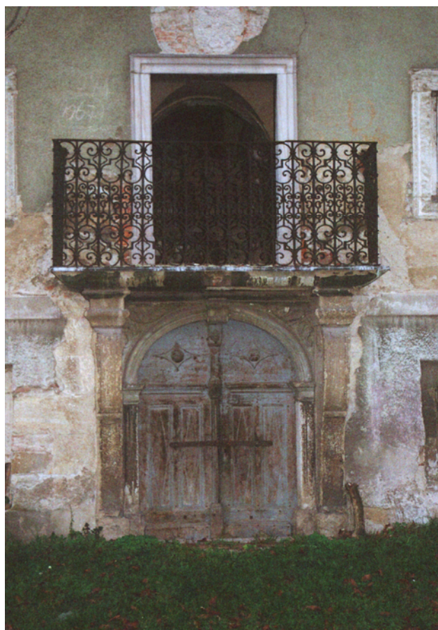
Slika 10. Pročelje na zahodni strani.
