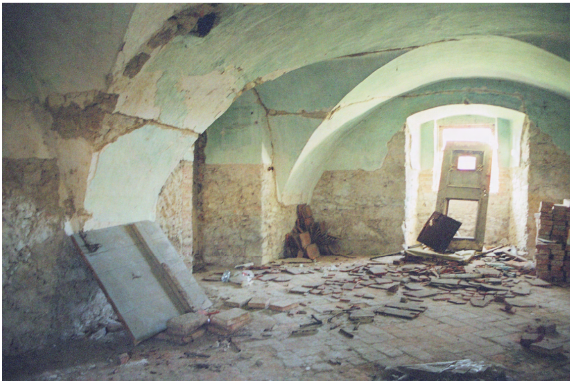
Slika 8. Pritlični prostor na severozahodu stavbe.
