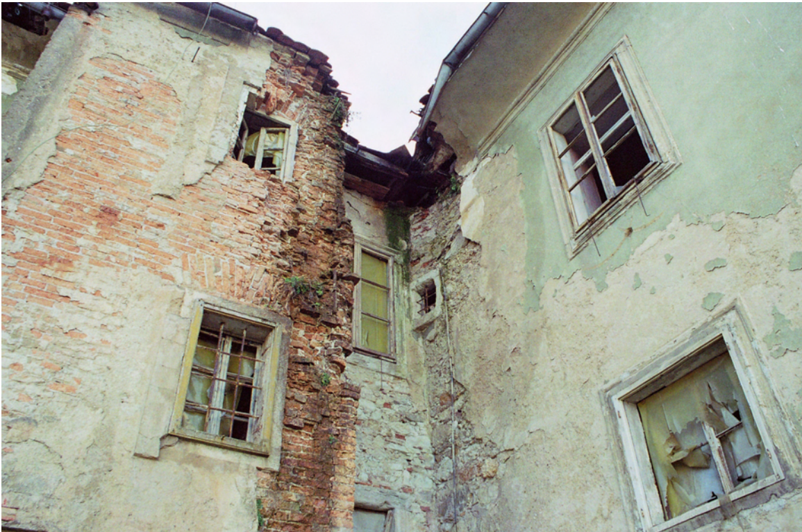
Slika 1. Izzidek na severni strani dvorca.
