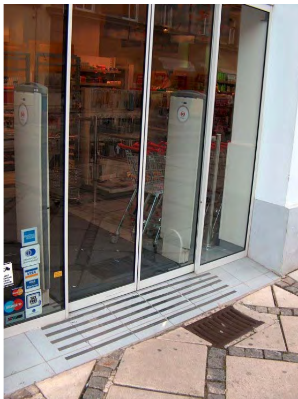
Foto 9: GIBALNO OVIRANIM OSEBAM PRIJAZEN VHOD, SLABOVIDNIM PA NEUSTREZNOST ODTEHTA AVTOMATSKO ODPIRANJE (foto: Denis Vrenko)
