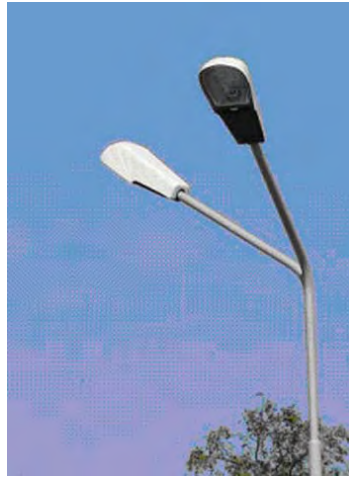
Slika 7: Napačno montirana svetilka
