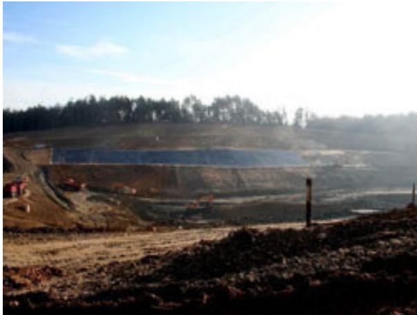
Slika 8: Izgradnja regionalnega centra
