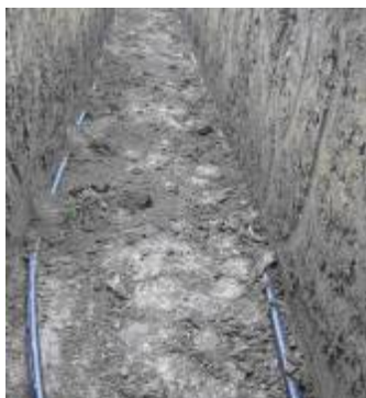
Slika 11: Klasični horizontalni kolektor.
