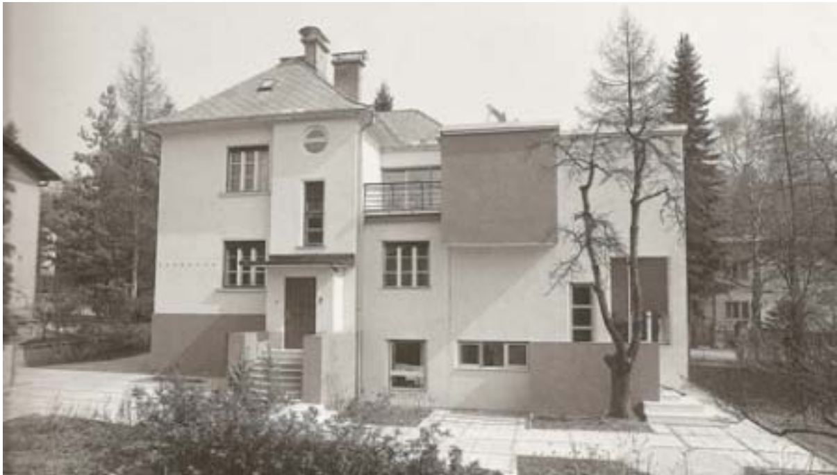
Slika 2 – prizidek hiše Paljk
