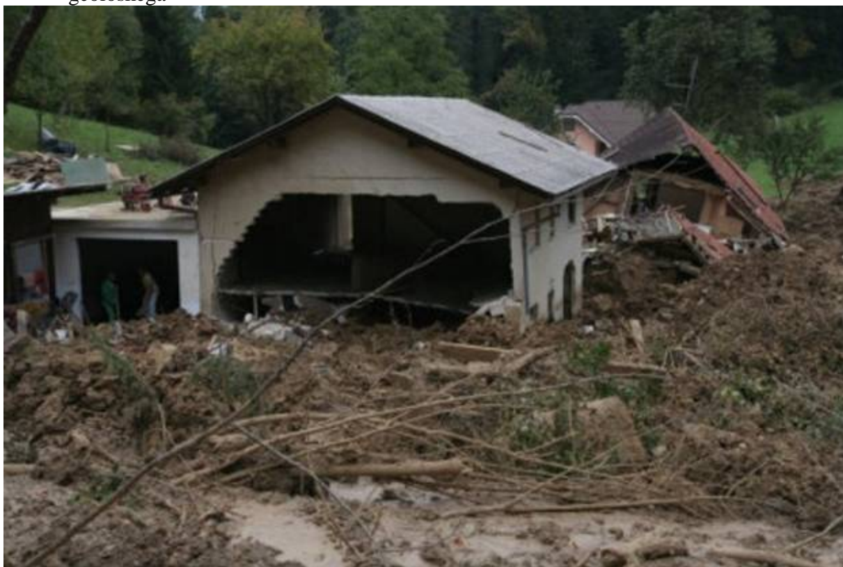
Slika 5: Porušena družinska hiša in gospodarski objekt
