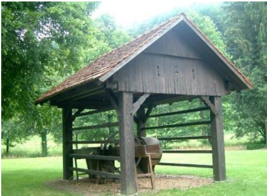
Slika 22: nadstrešek kot kozolec
