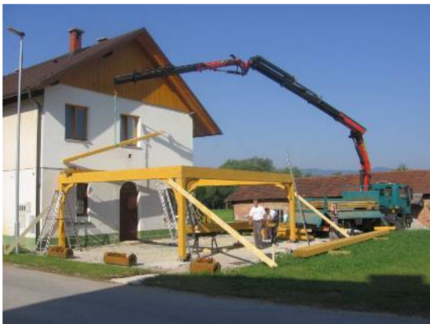
Slika 14: prva stopnja gradnje nadstreška
