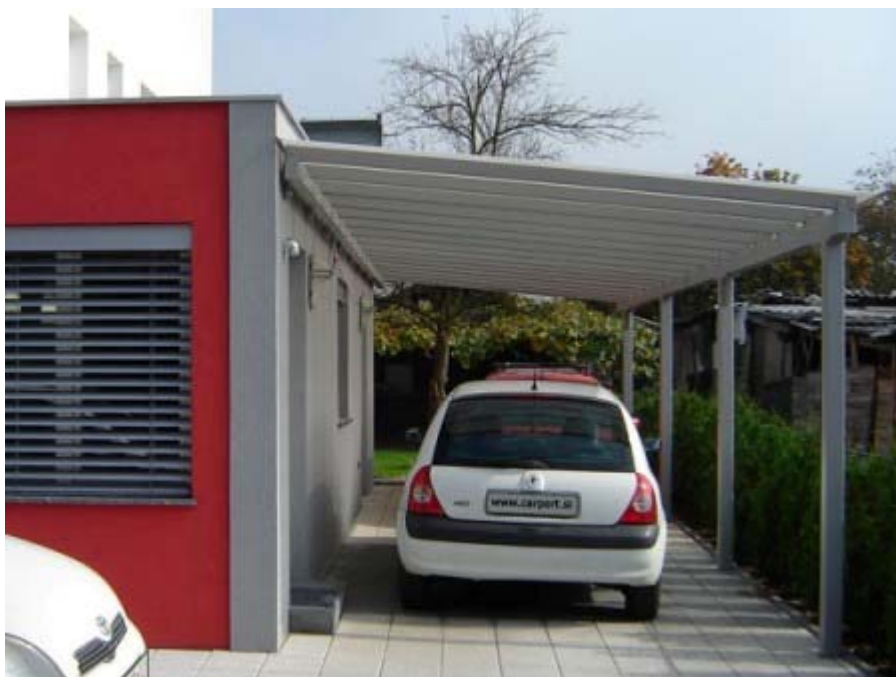
Slika 6: enokapni vpet kovinski nosilec
