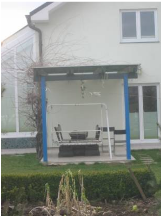
Slika 13: nadstrešek za zaščito terase
