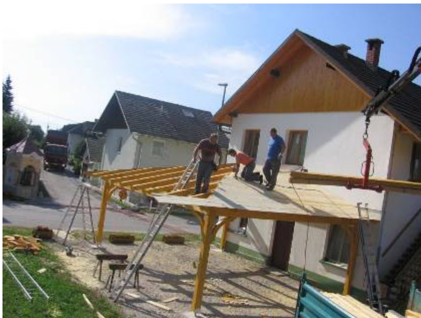
Slika 15: druga stopnja gradnje nadstreška
