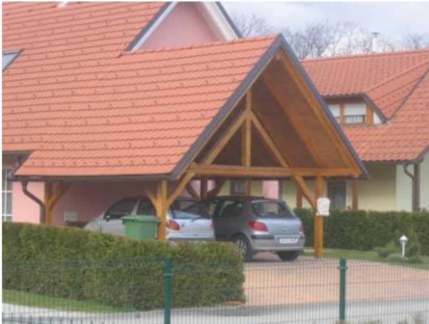
Slika 17: primer dvokapnega lesenega nadstreška
