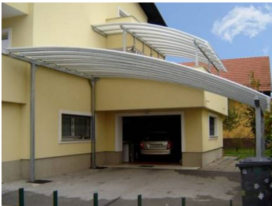
Slika 2: enokapni jekleni nadstrešek pokrit z polikarbonatno kritino
