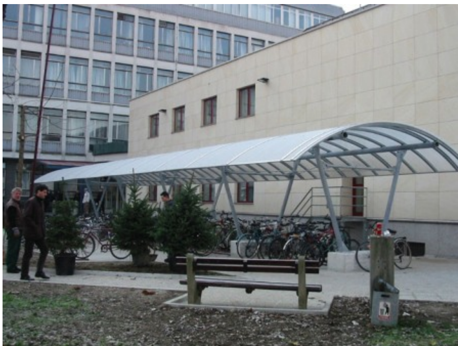
Slika 8: ločni kovinski nadstrešek uporabljen kot kolesrnica
