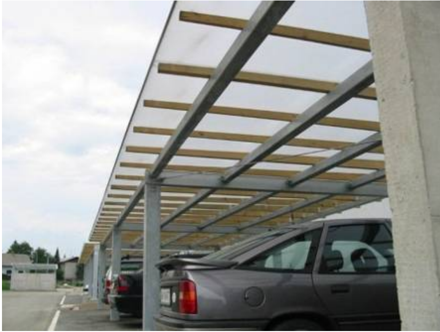
Slika 18: primer kovinsko - lesenega nadstreška kritega s polikarbonatno kritino
