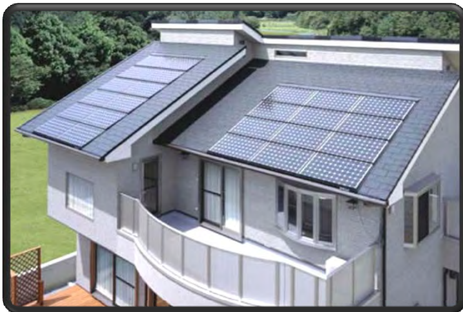
Slika 1: Sončni kolektorji, vir: internet
