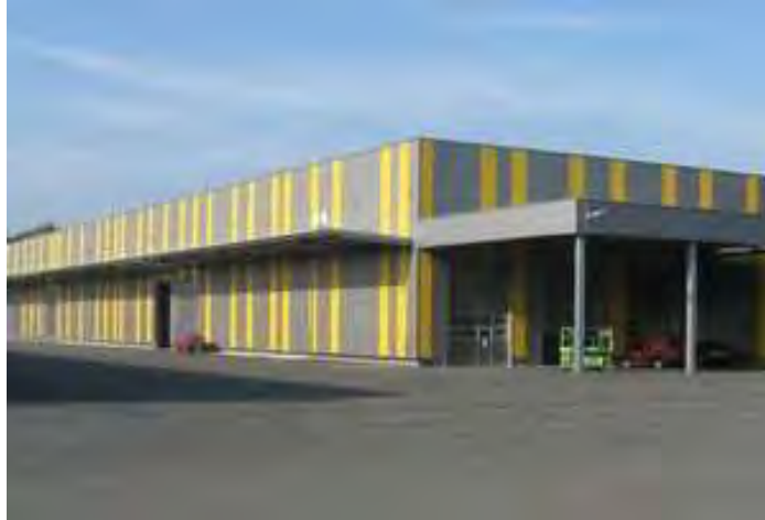
Slika 13: Sortirnica odpadkov v Bukovžlaku
