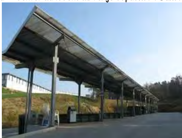
Slika 2: Center za ločeno zbiranje odpadkov v Bukovžlaku
