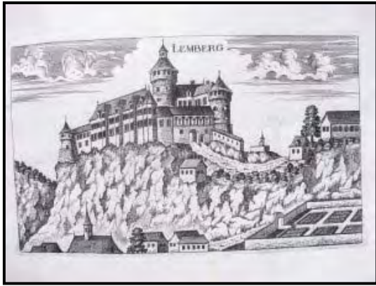
Slika 3: Grad Lemberg nekoč Vir: Stopar, I. (1990). Grajske stavbe v Vzhodni Sloveniji.
