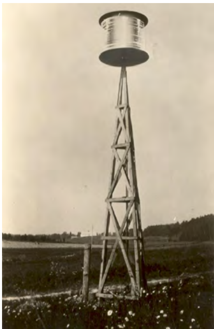
Slika 2: Savoniusov rotor
