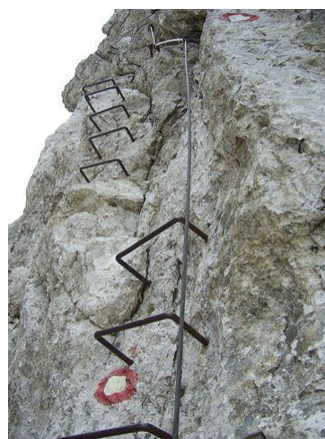
Slika 4: Pot na Tursko goro, opremljena s klini in jeklenicami (Pančur, 2007), desno
