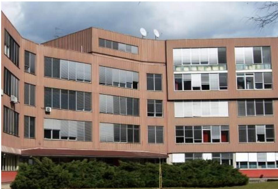
SLIKA 29: Pločevinasta fasada Šolskega centra Celje
