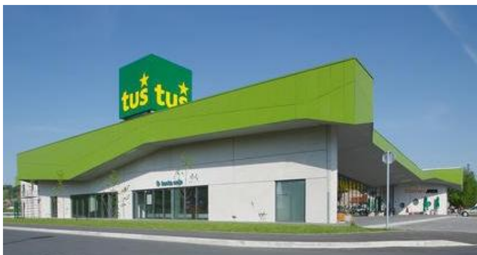
SLIKA 25: Supermarket Tuš Polzela, obložen z vlaknocementnimi ploščami.
