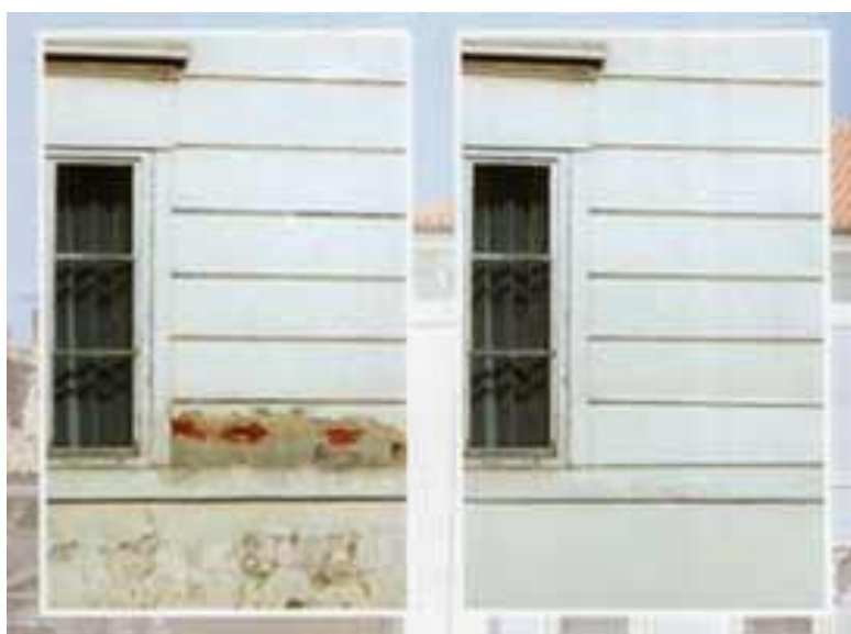
SLIKA 32: Fasada pred in po sanaciji
