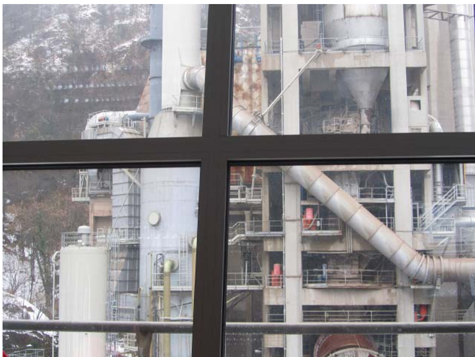
fotografija 3: Homogenizator, odžveplevalna naprava, odstranjevalec dušikovih oksidov, rotacijska peč Cementarna Lafarge Trbovlje (foto: Lea Vrhovnik, Marja Golež)
