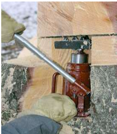
Slika 2: Podiranje z ročno hidravlično dvigalko
