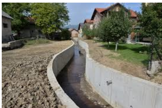
Slika 7 Primer reguliranega vodotoka
