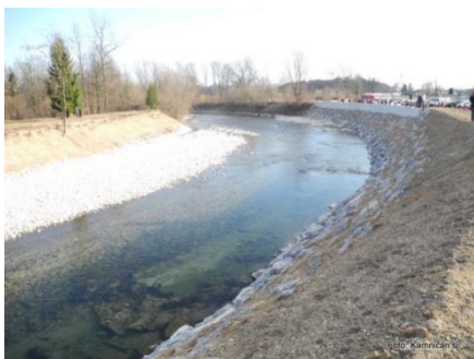
Slika 4 Primer zemeljskega nasipa
