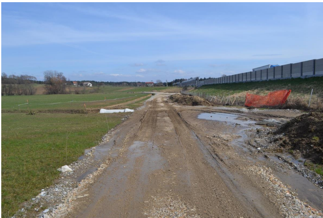
Slika 18 Gradbišče suhega zadrževalnika Ljubečna
