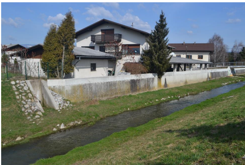
Slika 14 Nadvišan zid ob Koprivnici
