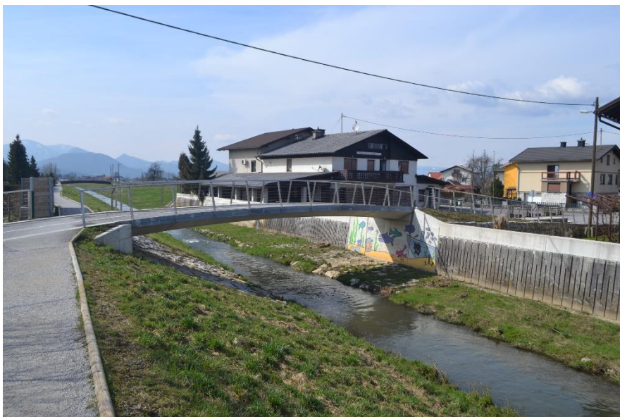
Slika 13 Nov most čez koprivnico
