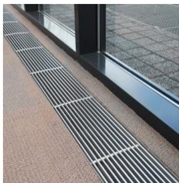
Slika 2: Talni konvektorji
