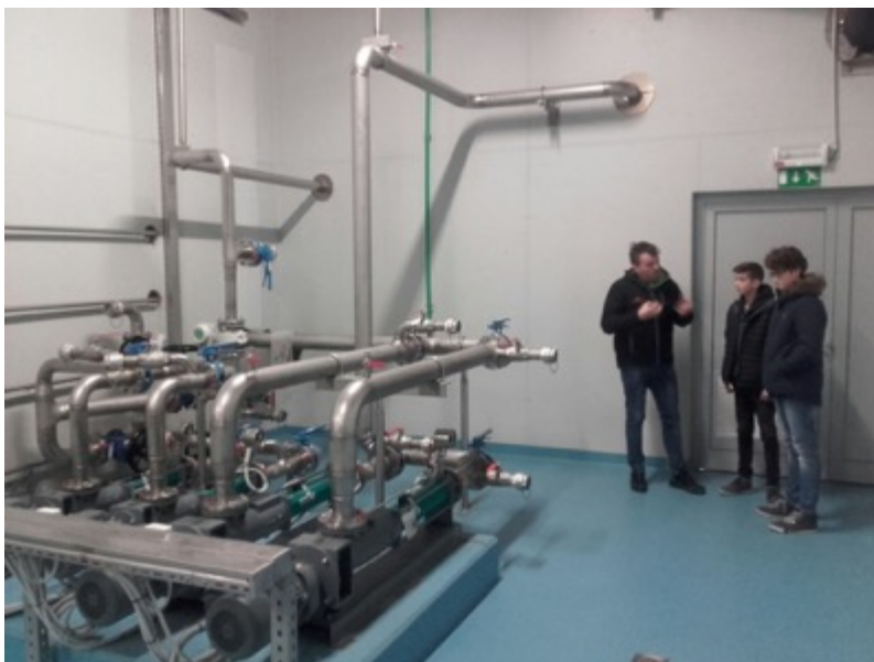
Slika 2:Dovod vode iz vrtine
