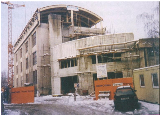
Slika 41: Srednja trgovska šola med nadgradnjo in gradnjo prizidka (1995)
