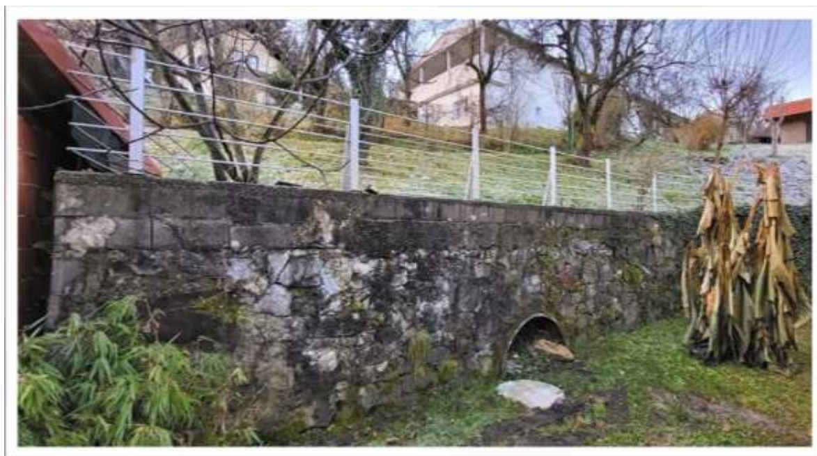
Slika 82: Izvirni podporni zid - škarpa nad Klinarjevo hišo z zasilnim izhodom iz rudnika Konstanca. Foto: Bojan Rebernak, 2023.
